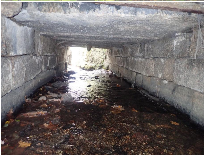
Podhled nosné konstrukce v původní části
